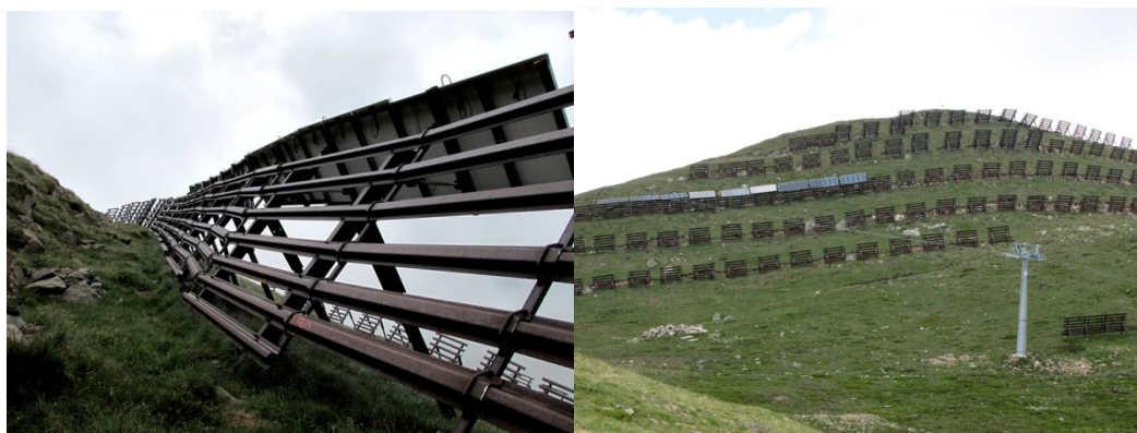
Foto 1./2. Pilotanlage EnAlpin, Juli 2012
